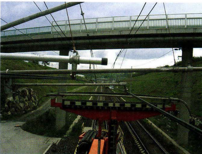
Bild 7: Prüfschleifleiste zur Messung der Fahrdrachtseitenlage und des Anhubfreiraums.
